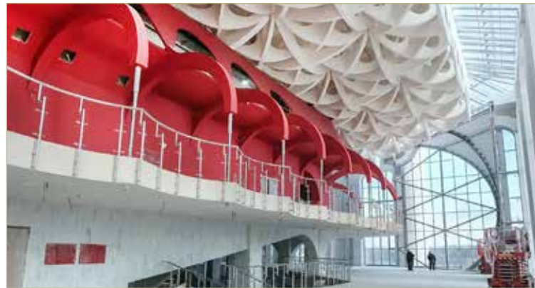
Структурные потолки выглядят ажурно и легко, но выполняют функцию несущих конструкций — жёстких и прочных.
