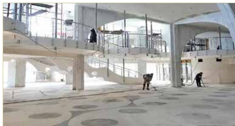
В покрытии пола повторили общую для здания тему с кругами.
