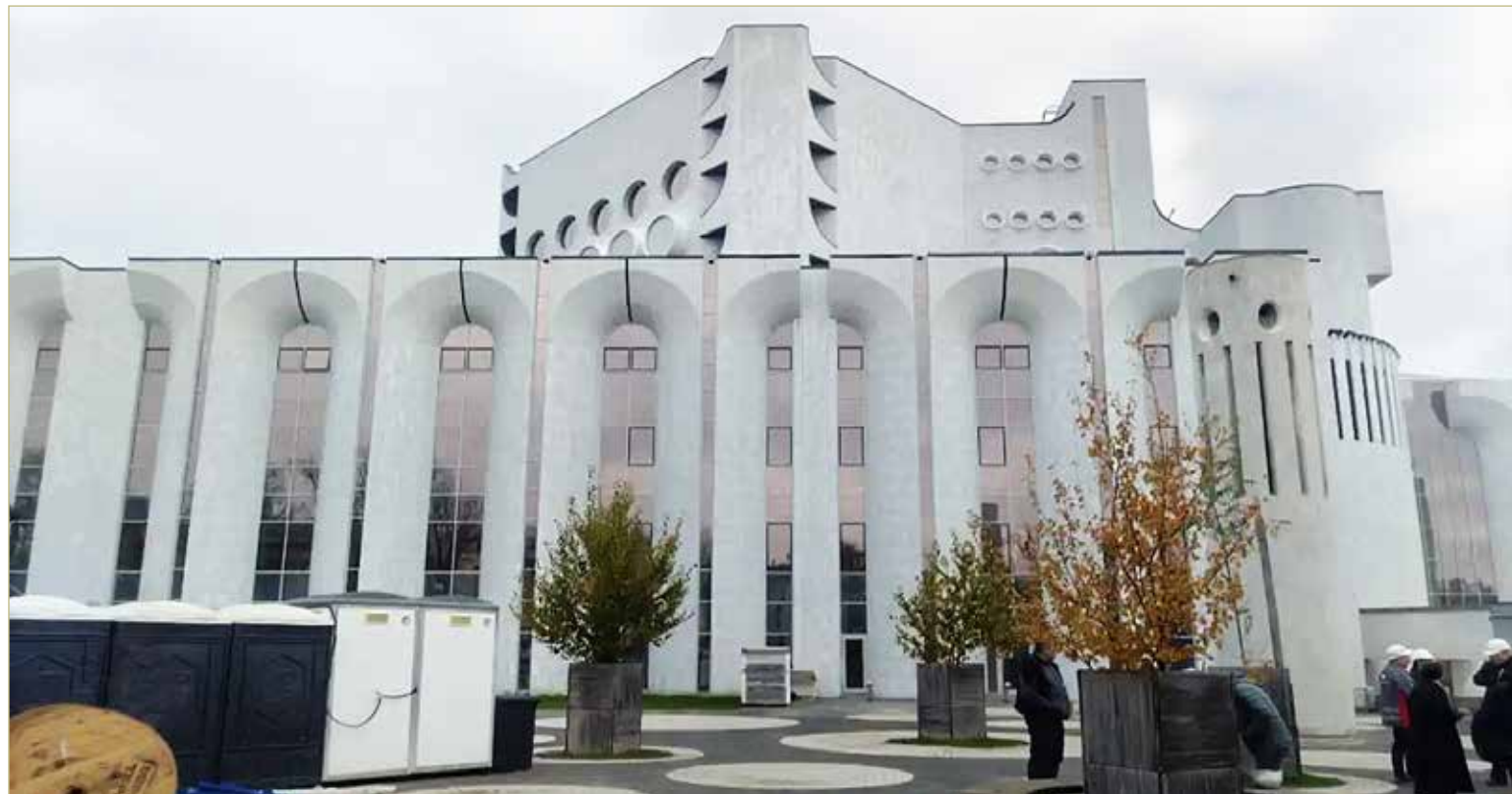
Здание новгородского театра преподнесло строителям немало сюрпризов.
